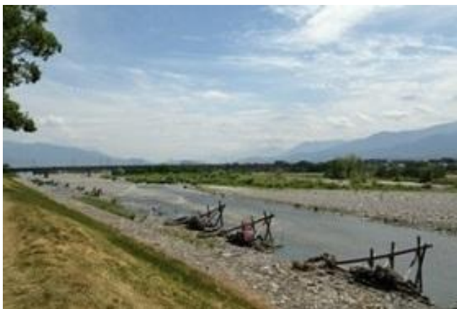
武田信玄時代から使われている聖牛による河岸保護
