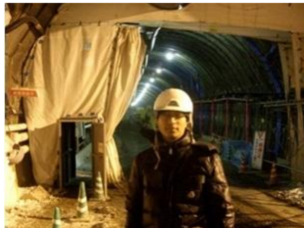
トンネル建設現場の見学
