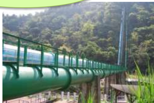
白冷圳の逆サイホン水管
