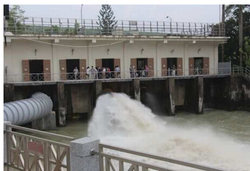
旧放水口からの特別放水
