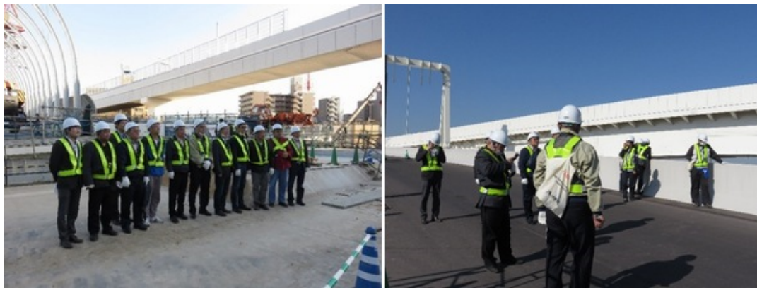
写真 3 首都高速・生麦 JCT 建設現場の現場見学会
