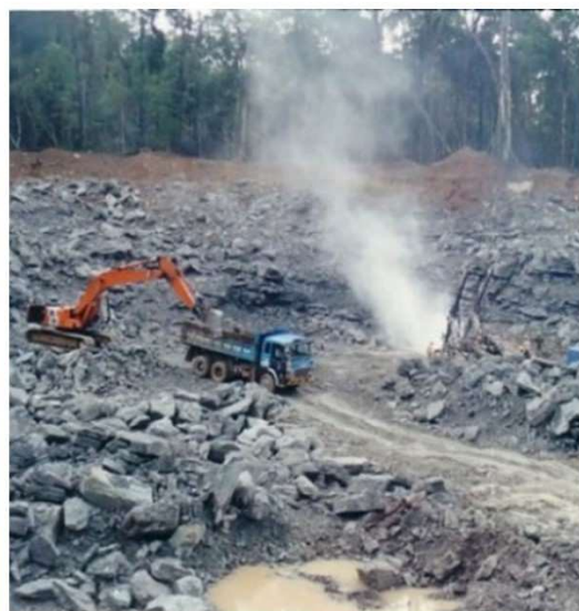
原石の採取状況（原石積込と発破用削孔）
