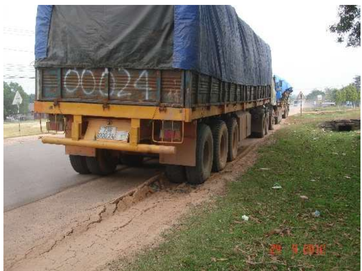
過積載車（ベトナムの車両）による旧舗装の損傷
