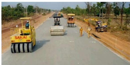
上層路盤の施工状況
