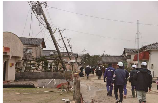
写真 1 珠洲市宝立町（津波浸水箇所、強震、液状化に津波が複合化して被災したエリア）
