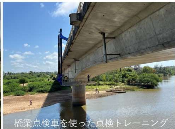
交通規制と橋梁点検車の設置状況
