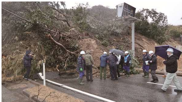
写真 2 珠洲市真浦町（国道 249 号逢坂トンネル付近の大規模崩落箇所）
