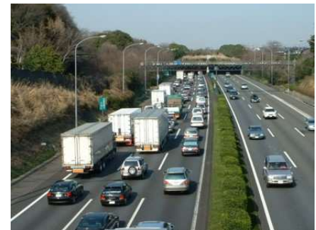
写真 1 大和トンネル付近の渋滞状況
