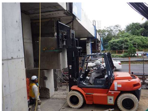
写真3 小割ブロックの搬出状況
