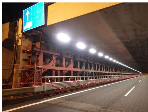
写真2 仮受支柱の設置状況
