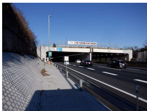
写真4 大和トンネル拡幅後
