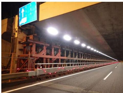
写真2 仮受支柱の設置状況
