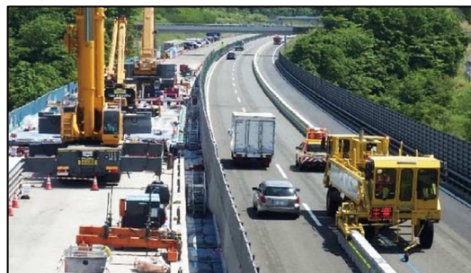
写真1 ロードジッパーシステムによる車線数の切り替え
