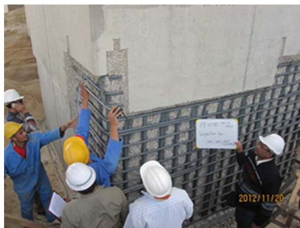
エジプト人技師による錆防止塗装検査
