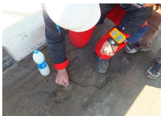
鋼床版減厚の測定
