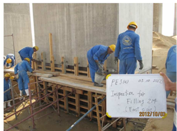
補修モルタルの注入
