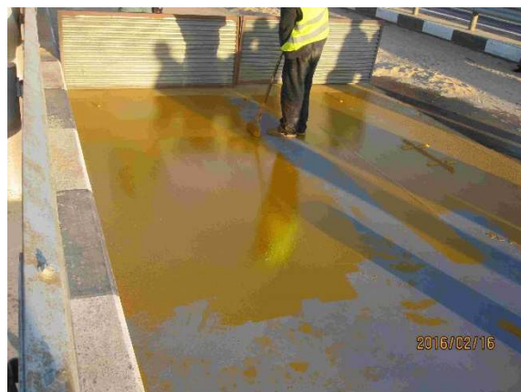
鋼床版表面処理後のプライマー塗布
