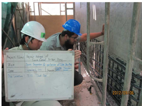
エジプト人技師による日本企業工事の検査
