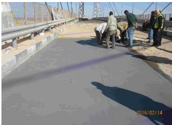
サドブラストによる鋼床版表面処理
