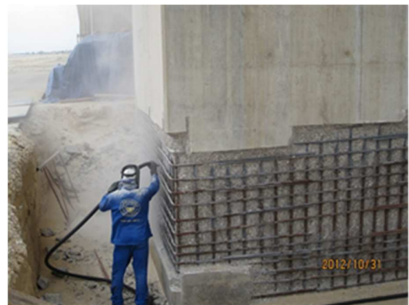
鉄筋錆の除去
