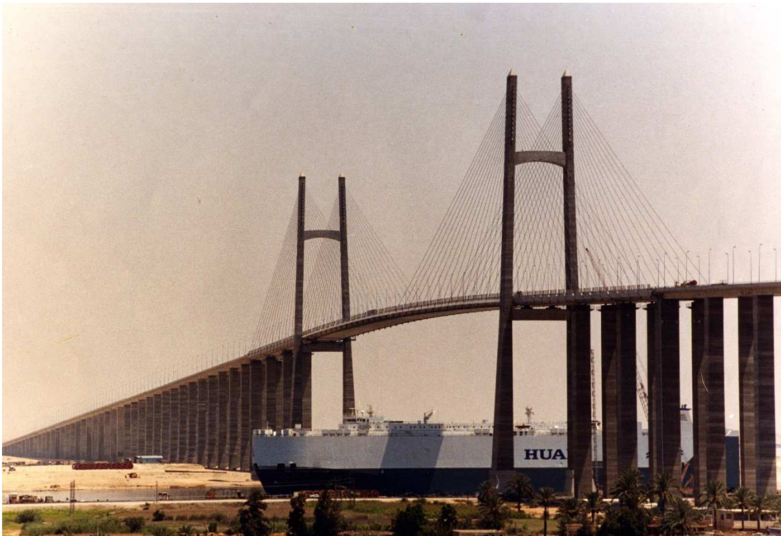
スエズ運河橋
