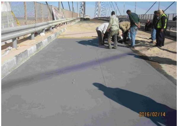
サドblastによる鋼床版表面処理
