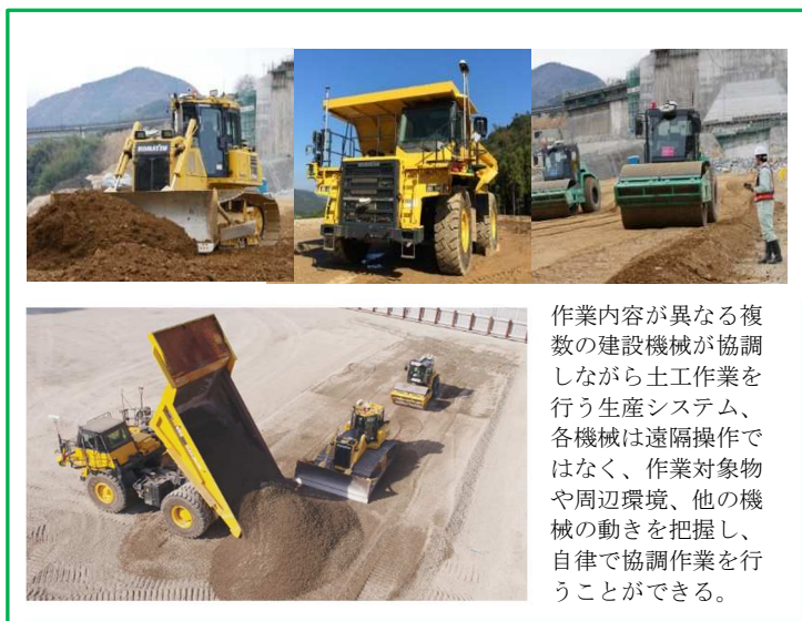
写真2 自律型建設ロボットの事例（鹿島建設・A4CSEL）
