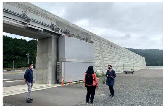
東北地方雄勝湾沿いに建設された、周辺地域を保護するための防潮堤
