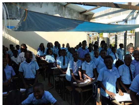
サイクロン被害で屋根が損傷したマクルンゴ小学校 (2019年5月)
