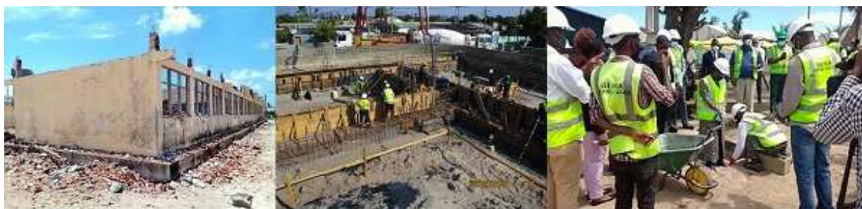
建設工事の状況
