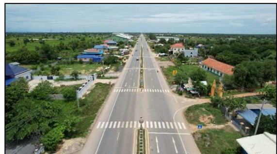
4車線化した道路（ルーラルエリア）
