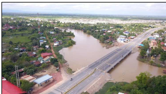
完成した道路橋（L=100m）
