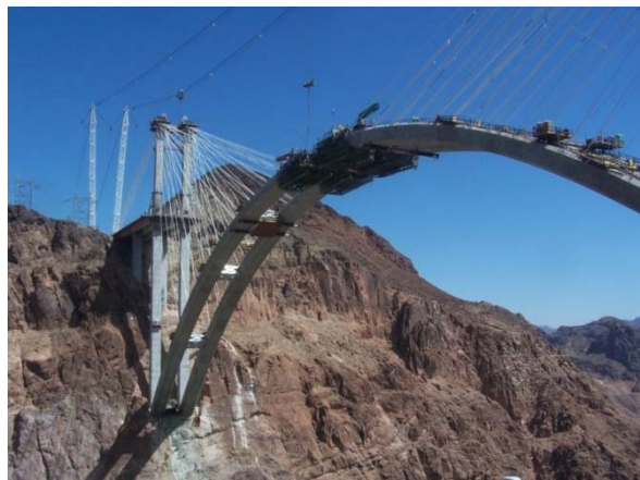
図4 コロラドリバー橋施工状況
