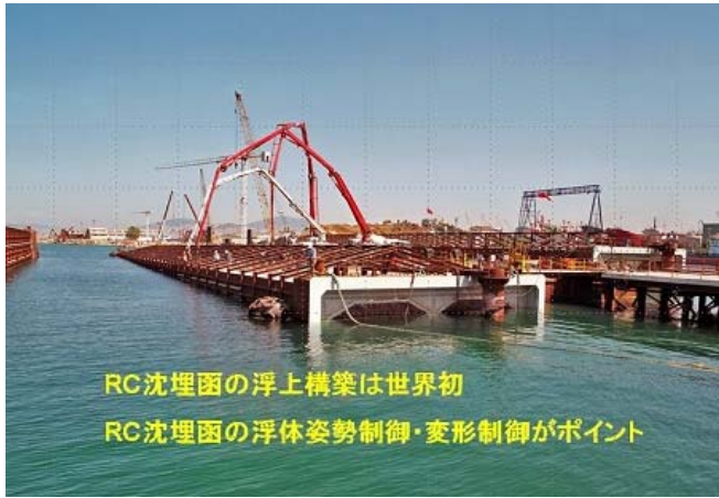
図6：RC沈埋函の浮上製作
