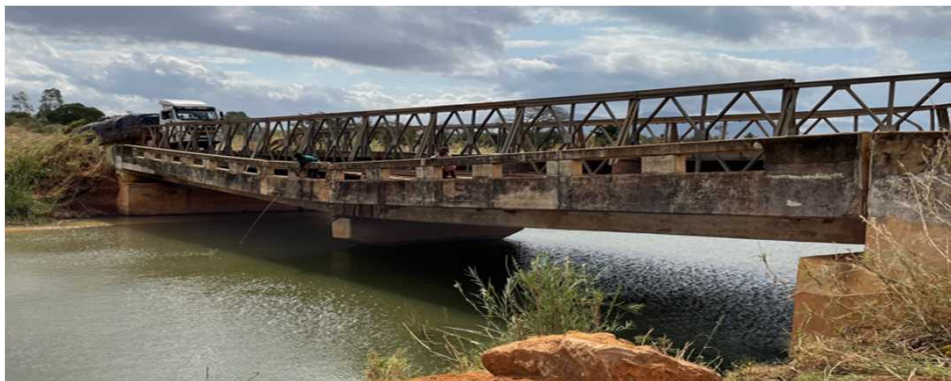
橋脚洗堀・沈下、ベイリー橋による復旧
