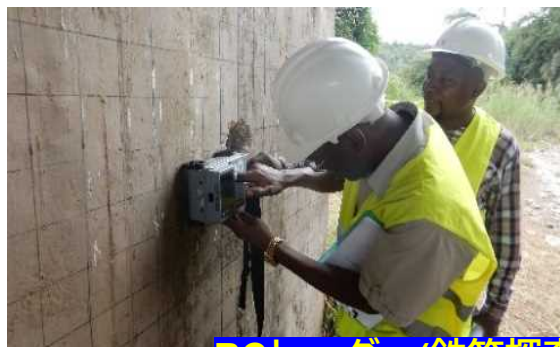
RCレーダー(鉄筋探査)
