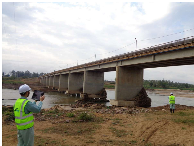
マプト州での現地調査
