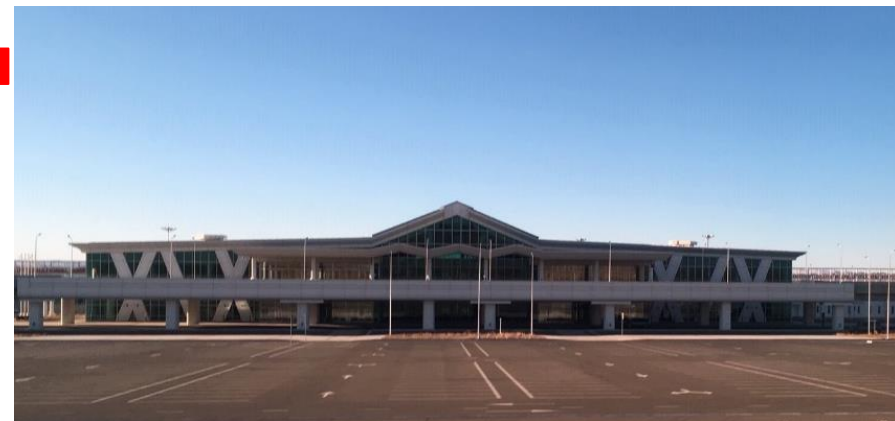
旅客ターミナルビル正面(ランドサイドから)
