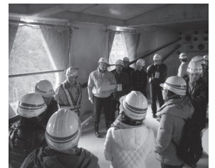
芥川橋工事にて
