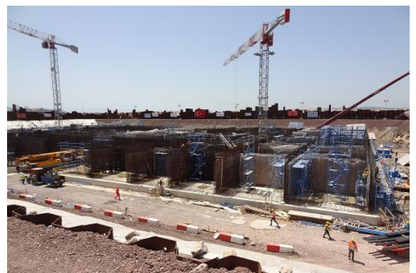
イズミット湾横断橋 建設現場
