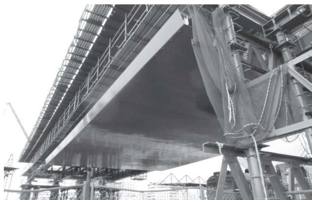
写真2 ウランバートル市で建設中の高架橋
