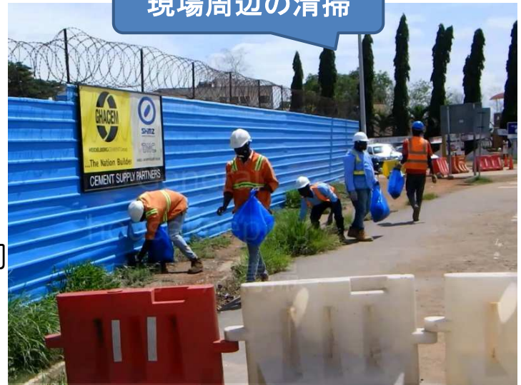
現場周辺の清掃
