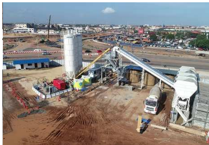
コンクリートの現地生産
