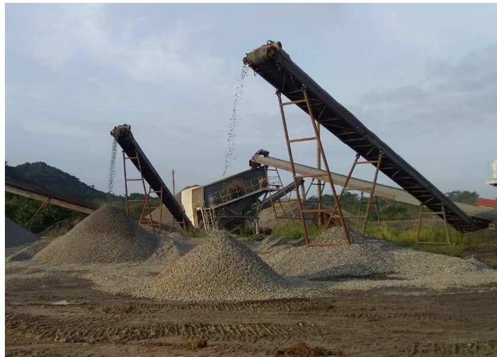
砕石場(コンクリートの骨材)
