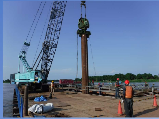
鋼管矢板打設状況
