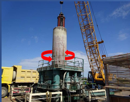
全旋回掘削機による先行岩盤掘削状況
