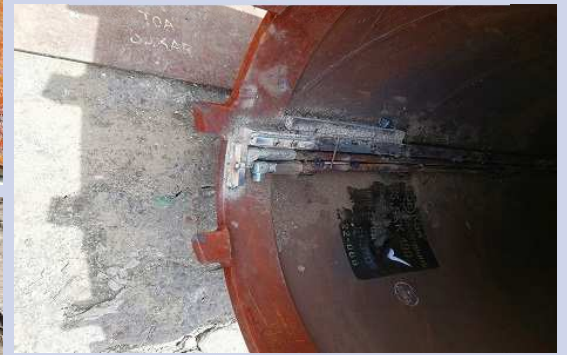
大口径鋼管 杭尻部配管
