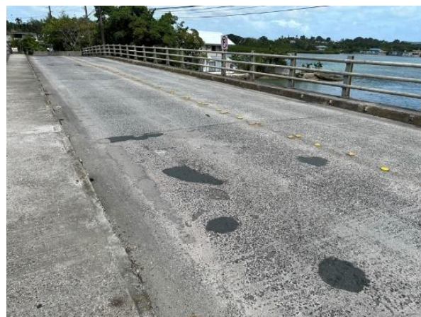
現在のミナト橋の様子（アップ）
