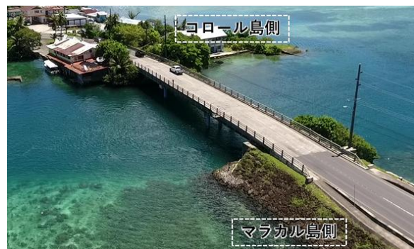
現在のミナト橋の様子（全景）
