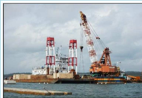
ブロック積岸壁工
