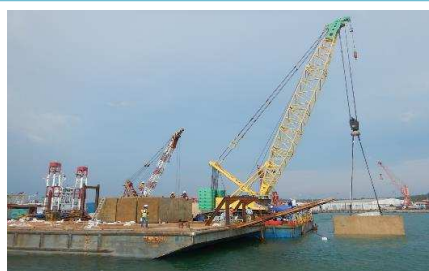
275ton クレーン船(ベトナム)
