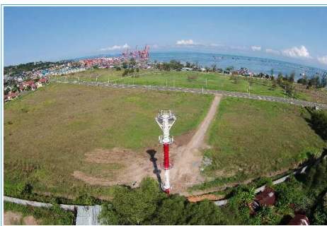
航路誘導施設
