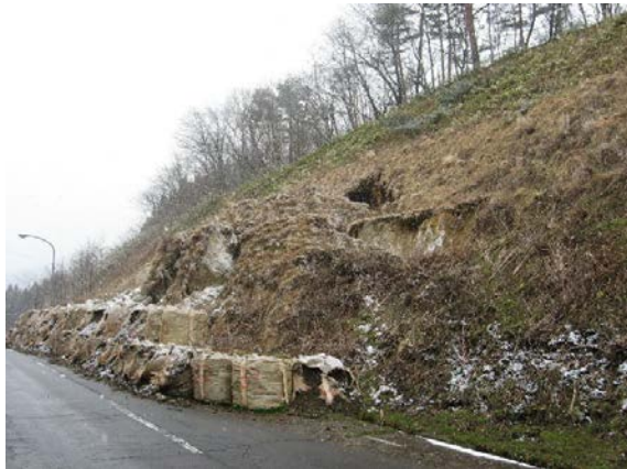
大型土のう（商品名コンテナバック） 耐候性：2ヶ月程度
