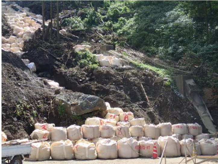
大型土のう（商品名コンテナバック） 耐候性：2ヶ月程度
