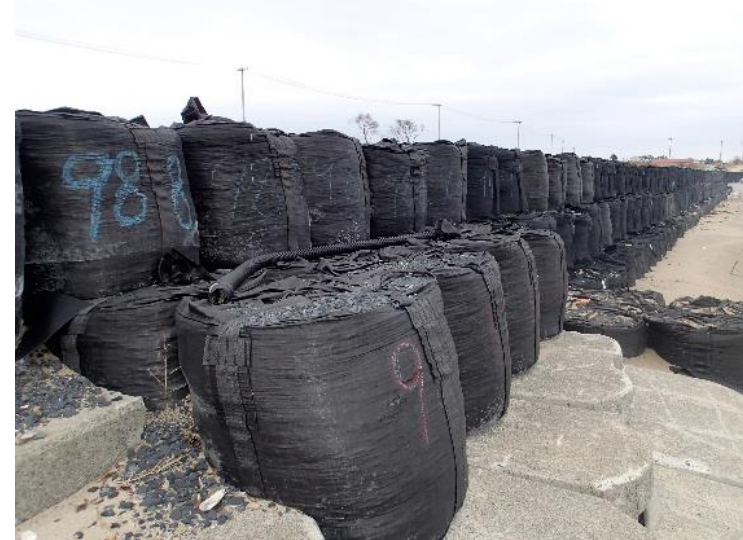
耐候性大型土のう（紫外線吸収剤使用） 耐用年数：3年程度
