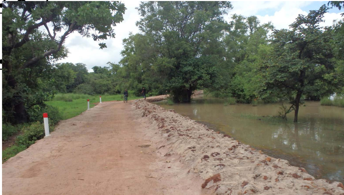
Construction de mur latéral
