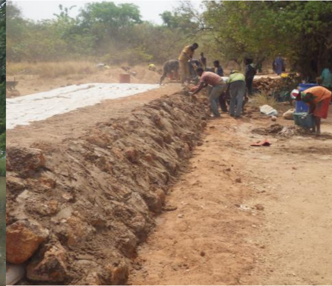
Construction de mur latéral
