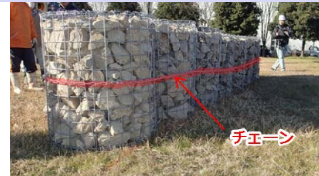
チェーンを巻付け緊張することで、構造の一体化を図る
