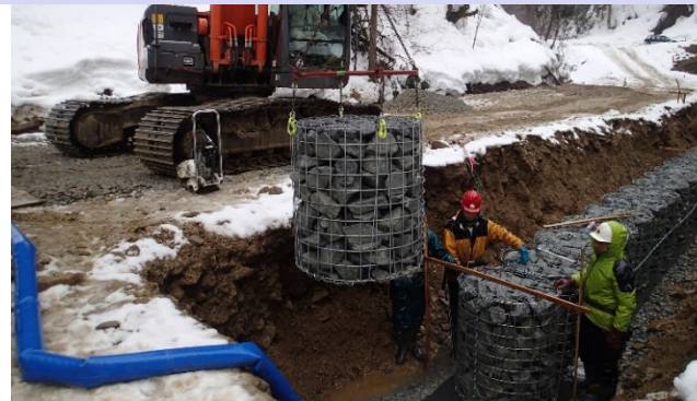
クレーン機能付きバックホウによる据付け
