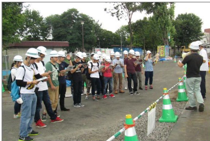
望月寒川改良工事現場
