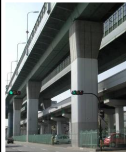
阪神高速道路の橋脚
