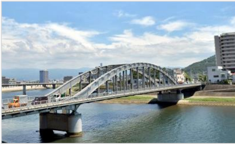
静岡県沼津市 御成橋
