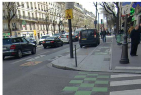
車道を削減し、自転車専用通行帯・駐車帯・植樹帯に変更、バスレーンの自転車通行を禁止
