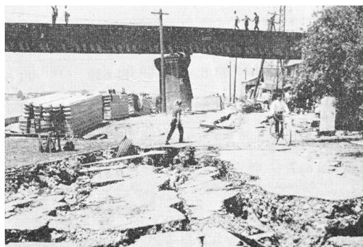
写真1 新潟地震の越後線橋脚の傾斜
