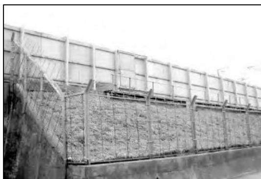
図 11 直型防音壁(東海道新幹線盛土区間)
