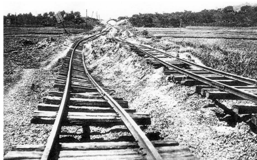
写真2 関東大震災の東海道線(現御殿場線)盛土の崩壊
