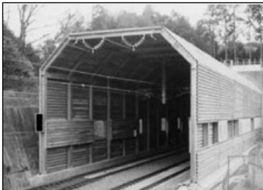
図 23 トンネル緩衝工
