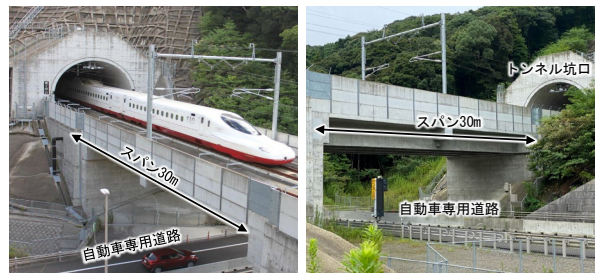
写真9 PC 桁を用いた橋長 30m の GRS 一体橋梁
