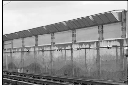
図 18 新幹線用先端改良型防音壁(NIDES-AL)
