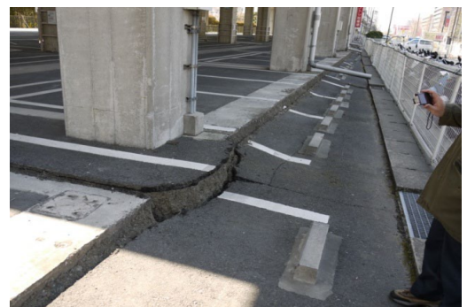
写真8 東北地方太平洋沖地震の京葉線高架橋(無被害)
