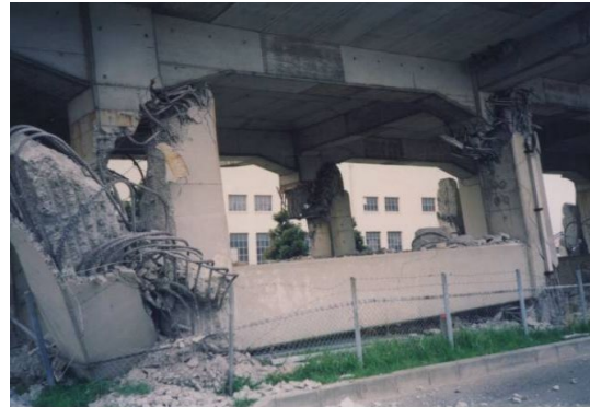
写真 4 兵庫県南部地震の JR 神戸線高架橋の崩壊
