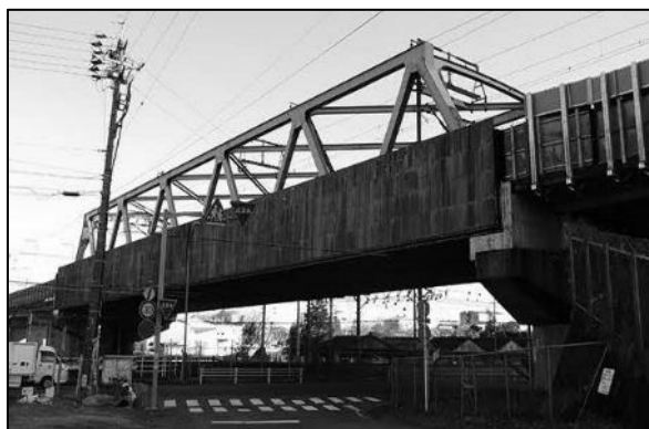
図9 鉄桁防音工(全体)
