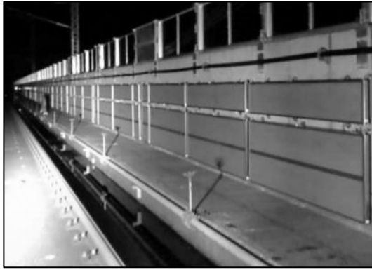
図 19 吸音板の設置
