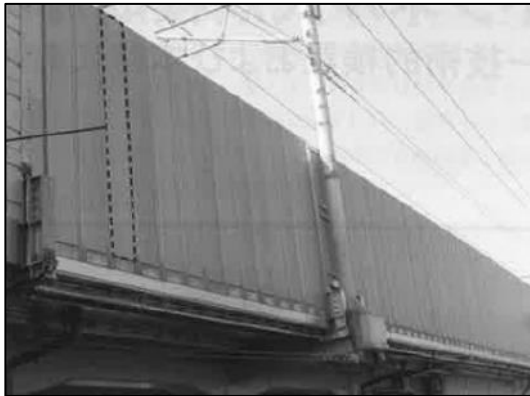
図 21 大規模改修工事における新型防音壁
