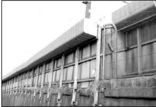
図 17 干渉型防音壁(ラムダ型)
