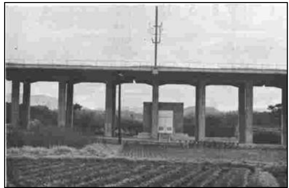
図3 防音壁の無い東海道新幹線開業時の高架橋
