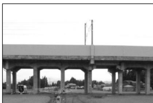
図 13 場所打ち RC 壁(東北新幹線(盛岡以南))
