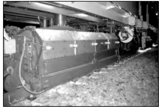
図6 レール削正の作業状況
