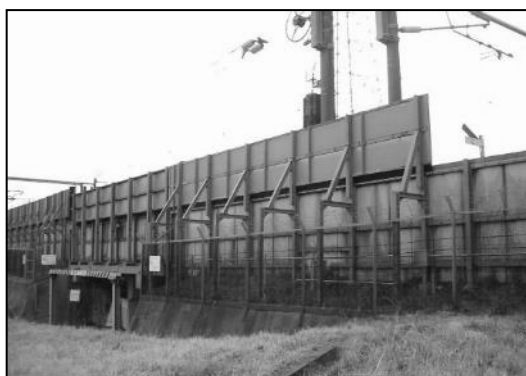
図 15 防音壁の嵩上げ
