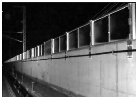
図 16 防音壁の嵩上げ(透明板)
