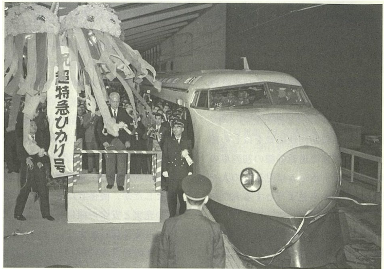
東海道新幹線出発式、石田総裁によるテープカット(東京駅19番線ホーム)(1964年10月1日)
