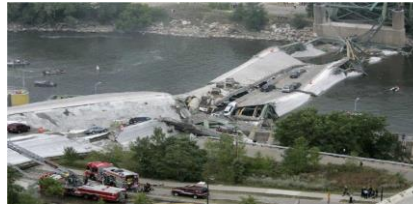
ミシシッピ川橋落橋事故
