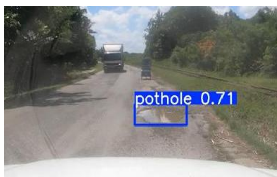
図 3 舗装損傷の検出結果（最適化後）
