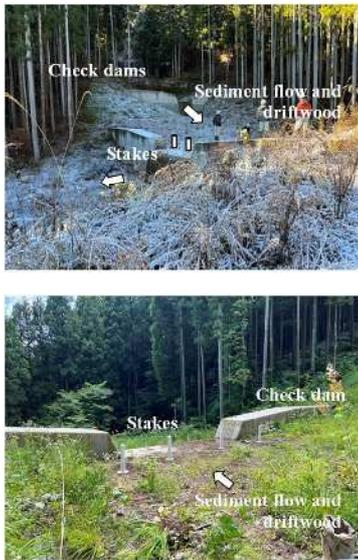
図-5 螺旋型杭基礎を活用した流木捕捉工の設置例（上：隣接する林道から撮影，下：堆砂域から設置後に撮影）
