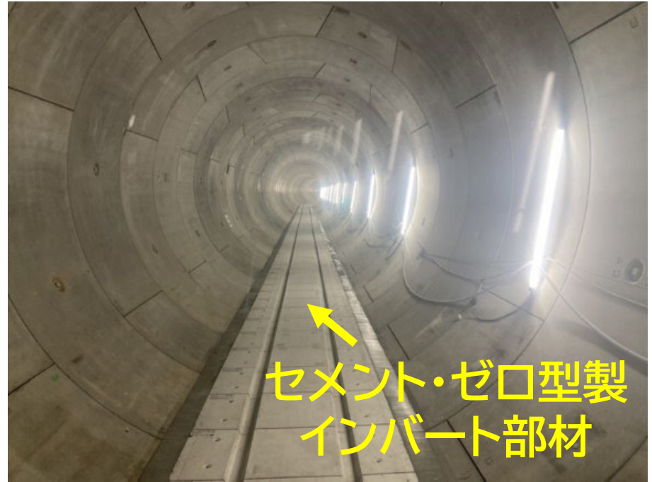
インバート現場設置状況 (セメント・ゼロ型)
