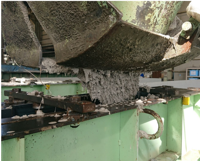
インバート製造状況 (カーボン・リサイクル)
