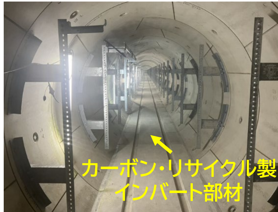
インバート現場設置状況 (カーボン・リサイクル)
