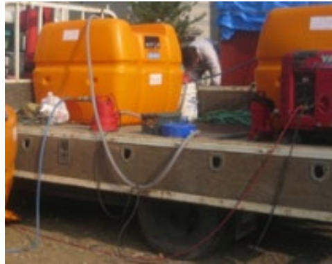
車載したタンクにアスコルビン酸溶液を調整
