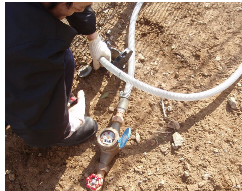
浄化壁内部に薬液供給
