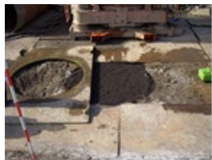
④ 浄化壁打設完了
