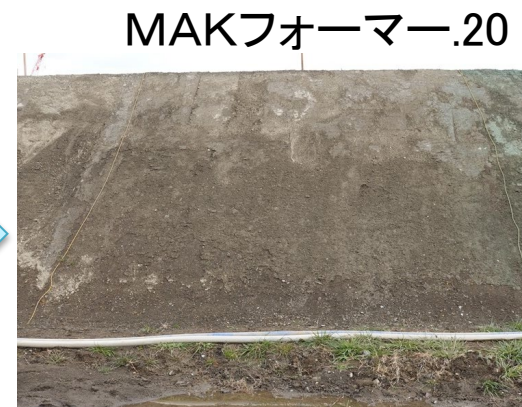
施工後129日の法面
