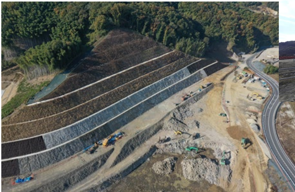
中国地整・小田川付替え南山掘削他工事
