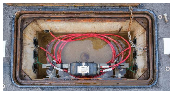
図-3 河川管理用光ファイバの敷設状況 3)
