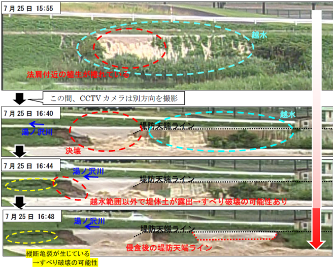
図-2 今次出水の越水や川裏すべりの時系列変化 1)
