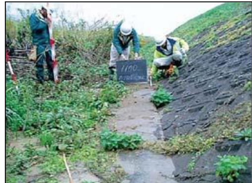
写真② 堤外地の噴砂の状況
