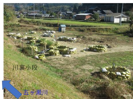
図-1 地盤漏水の対策状況
