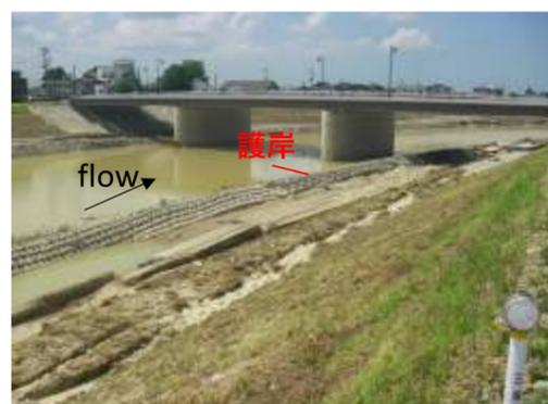
図-2 H23 年洪水時 内岸側高水敷・低水護岸被災状況(1.1km)<sup>5)</sup>
