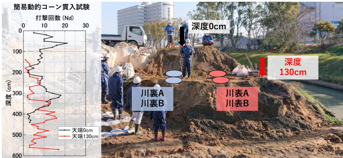
写真1. 半場川堤防開削断面
