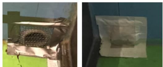
図 3 排水孔呑口の処理
