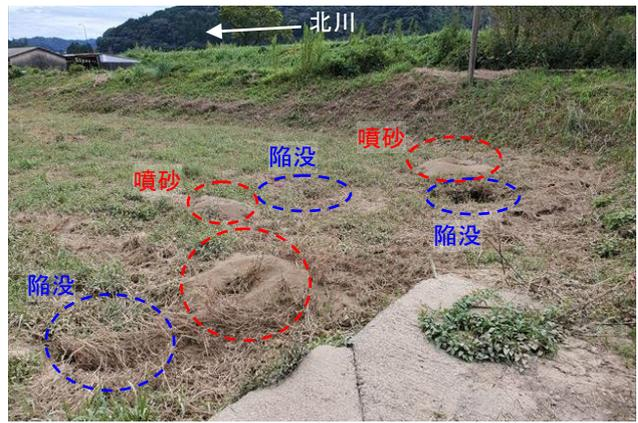
写真-1 噴砂および陥没 (漏水箇所②)
