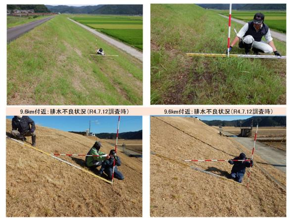
写真4 小段部排水不良状況(上段) 一枚法化状況(下段)
