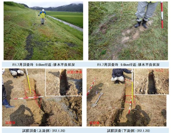
写真3 中筋川中島地区排水不良状況(上段) 試掘調査状況(下段)
