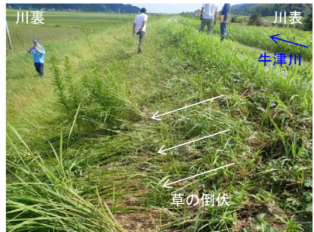
図-2 越流による植生の倒伏状況
