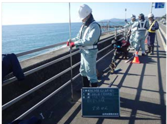
図-5 周辺の空洞確認のための簡易貫入試験
