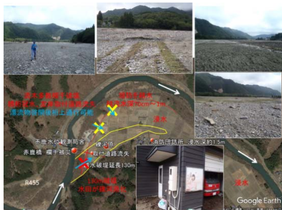
図-10 セグメント1の越水による決壊・破堤の事例
