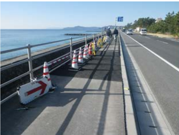
図-4 復旧後の堤防天端の様子
