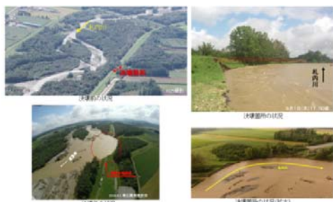
図-9 セグメント1における側岸侵食による決壊・破堤
