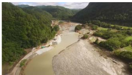
写真-3 セグメント1における護岸・道路の崩壊・流失と応急復旧の難航
