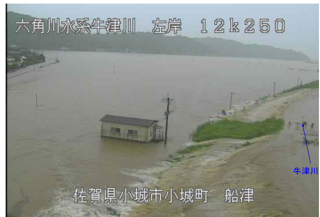
図-1 牛津川左岸12.2k越流状況 (九州地方整備局提供)
