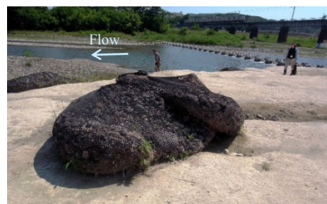
図-2 移動した袋詰玉石工の近景
