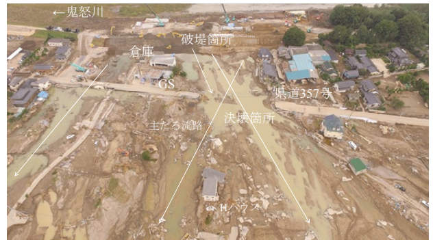
写真—3 堤内地の落堀： 国土交通省関東地方整備局の提供
