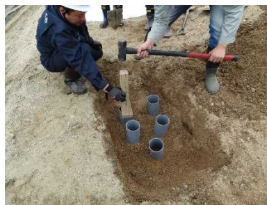
図2 塩ビ管の打ち込み（方法 A）
