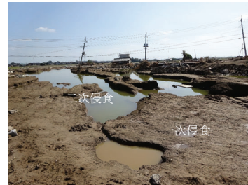
写真—4 堤内地に形成された落堀： 9月26日
