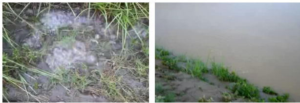
図- 1 実堤防で見られたエアブロー現象
