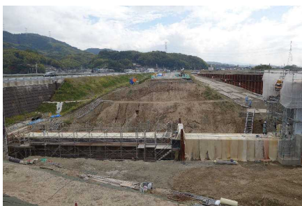
図1 開削工事中の堤防
