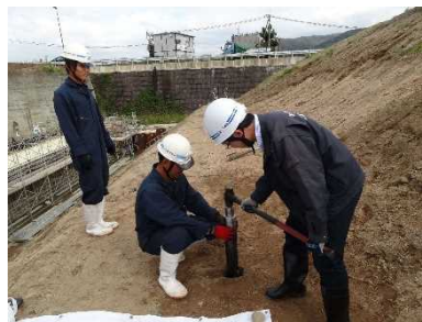
図5 サンプラーの打ち込み（方法 B）
