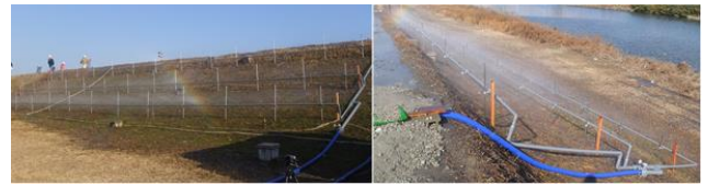
図-10 散水の様子 左：矢田川側，右：庄内川側
