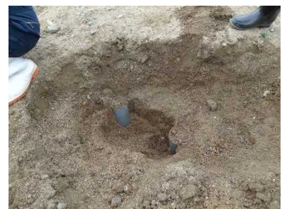
図3 塩ビ管の掘り出し（方法 A）
