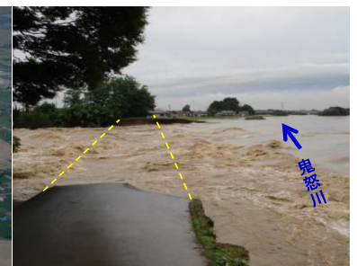
被災状況(拡大写真)
