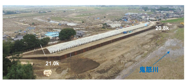
応急復旧状況(9/24)
