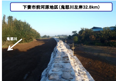
9月23日 大型土のう設置終了 (L=340m)
