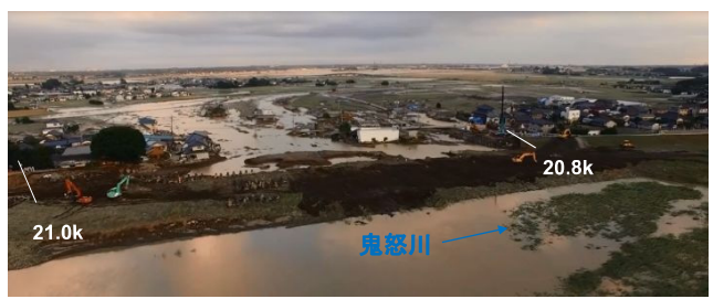
応急復旧状況(9/12)
