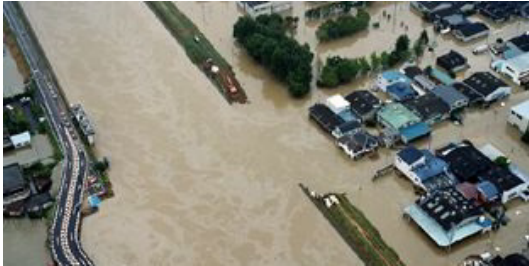
図-1 東海豪雨による新川堤防決壊箇所[2].
