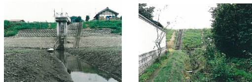
川表側 川裏側 設置年：昭和12年 主な応急対策工事：門柱付け替え(S60) グラウト対策(S62, H11) 函体構造：0.6m(管径)×1連×18.0m(長) 基礎形式：函体 木杭4.0m 門柱 支持杭17.0m
