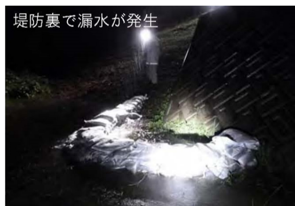
図-4 牧田川(左岸11.2k附近)の堤防裏の漏水状況 6)
